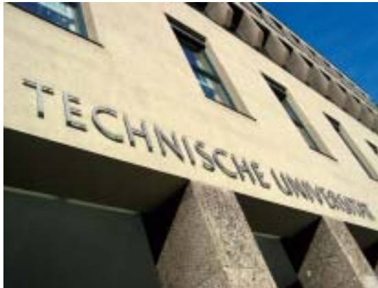
Hauptgebäude der TU München Main building of the TU Munich
